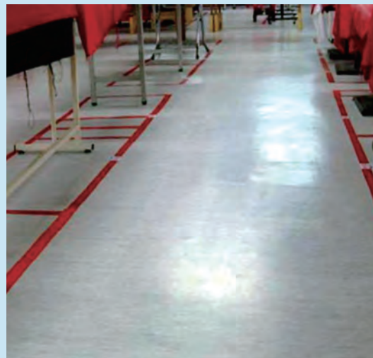
無接縫PVC地坪重量輕，可減輕整體結構荷重。
