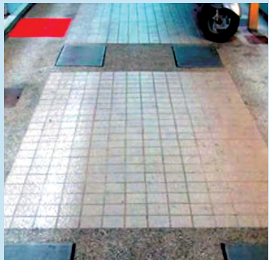
中間走道鋪設止滑地磚，分隔處及利用振石子收邊，使地磚完整且增加美觀效果。
