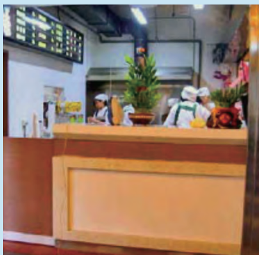
1.工作檯檯面施作不鏽鋼包覆，易清洗且耐久性佳。2.櫃檯檯面施作美耐板包覆，美觀大方。
