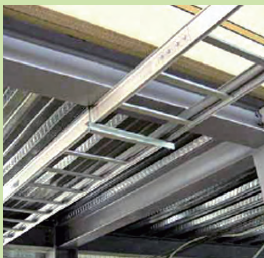
鋁合金集線槽，採明架式設計，易於收納管線。
