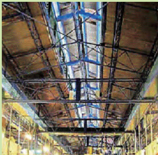
挑高設計 + 無動力排風扇： 兼具通風及採光效果。
