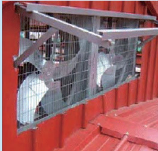
負壓式排風扇利用對流原理迅速排出市場之熱氣。
