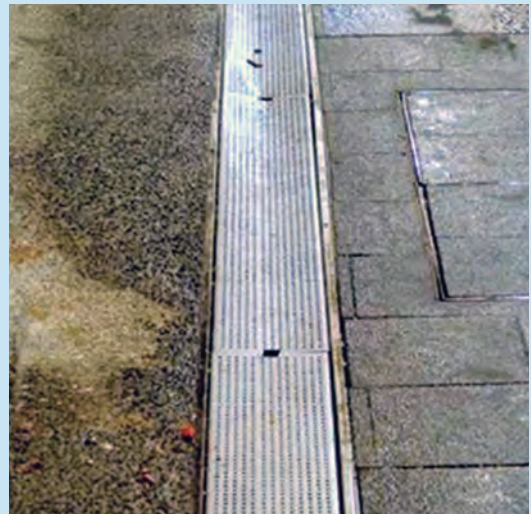
不銹鋼格柵板水溝蓋使用年限長且易清洗。
