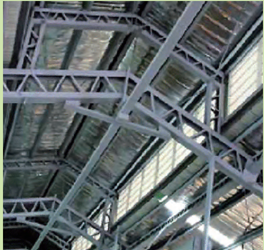
太子樓屋頂 + 鏤空頂板鐵網架通風性佳
