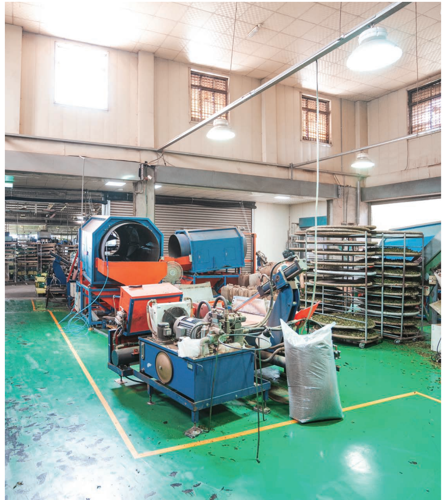
東大製茶廠，改善病媒防治與生產動線，防止人員進出導致交叉污染。
