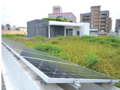
屋頂設有太陽能板且有綠色植栽。
