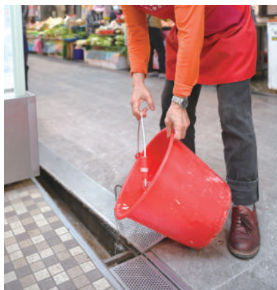
市場設有加蓋排水溝，每日收攤後清潔維護衛生。
