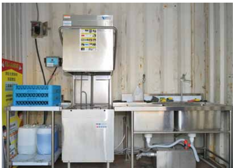
為推動重複清洗餐具，設置專屬洗滌區及油脂截留槽。
