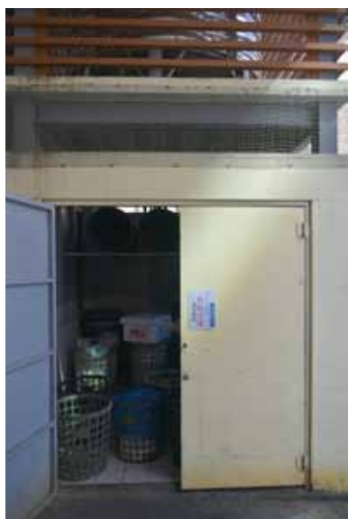
設置垃圾處理專區並搭設鐵網避免老鼠侵擾。
