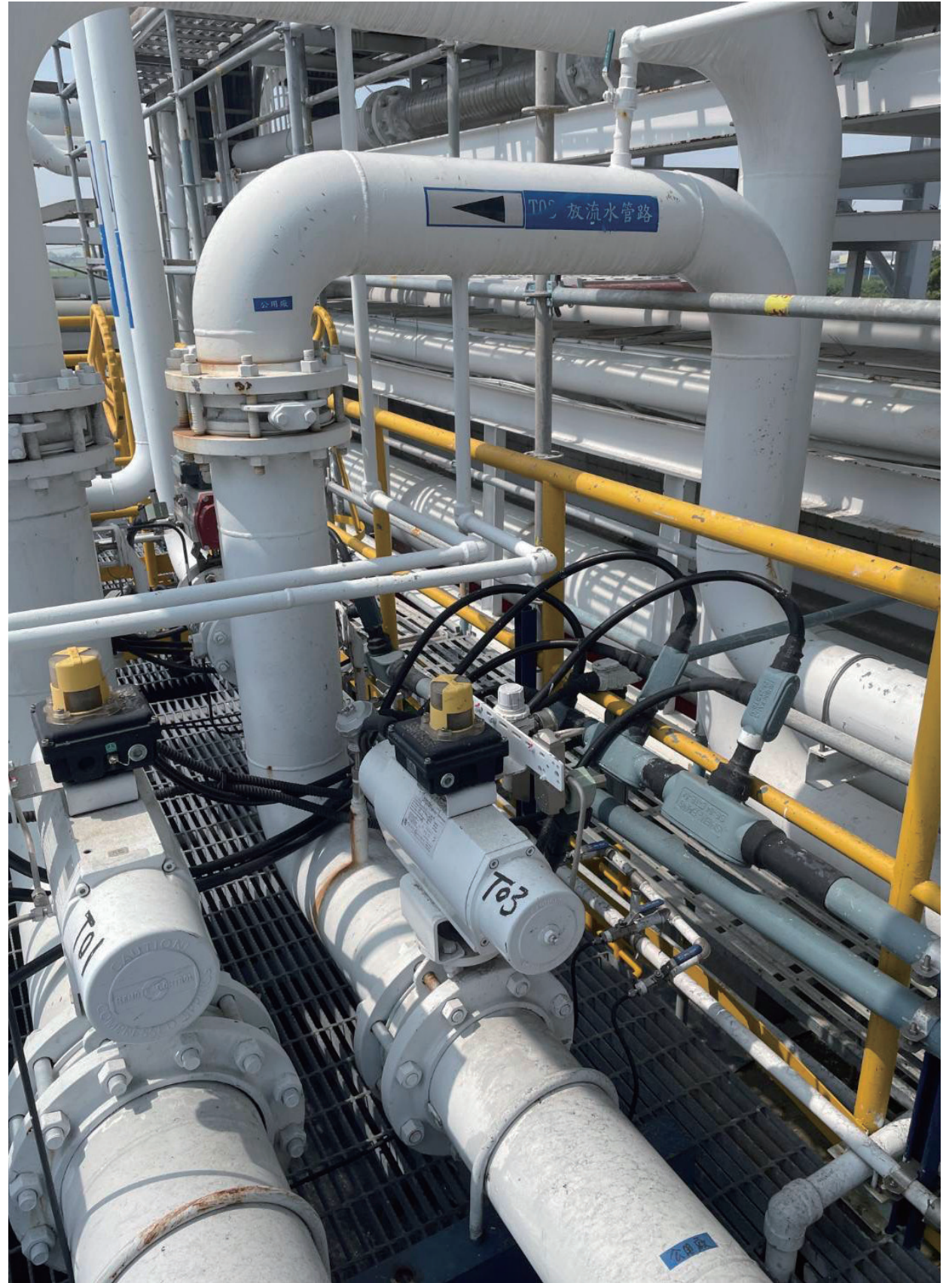
李萬吉創業當年參與台塑六輕工程，處理配管工程、鋼構安裝與現場維修。（圖片提供 / 李萬吉）
