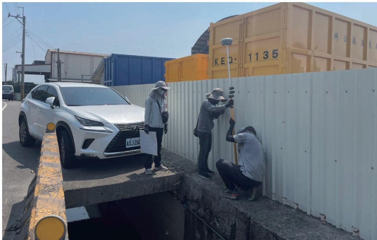
銘峰參與用地變更輔導，事先界定土地邊界，預計拆除原有建築物。
