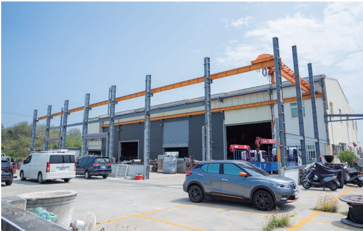
立昌寶申請用地變更計畫已獲核准，準備拆除在隔離綠帶的部分廠房，以符合法規，爭取早日工廠合法化。
