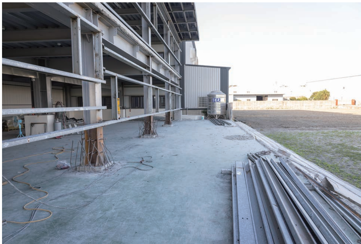
立寬申請用地變更計畫獲得核准，工廠依法規劃設 1.5 公尺的隔離綠帶或設施，立寬則拆除部分工廠，多退縮 3 公尺符合規範。
