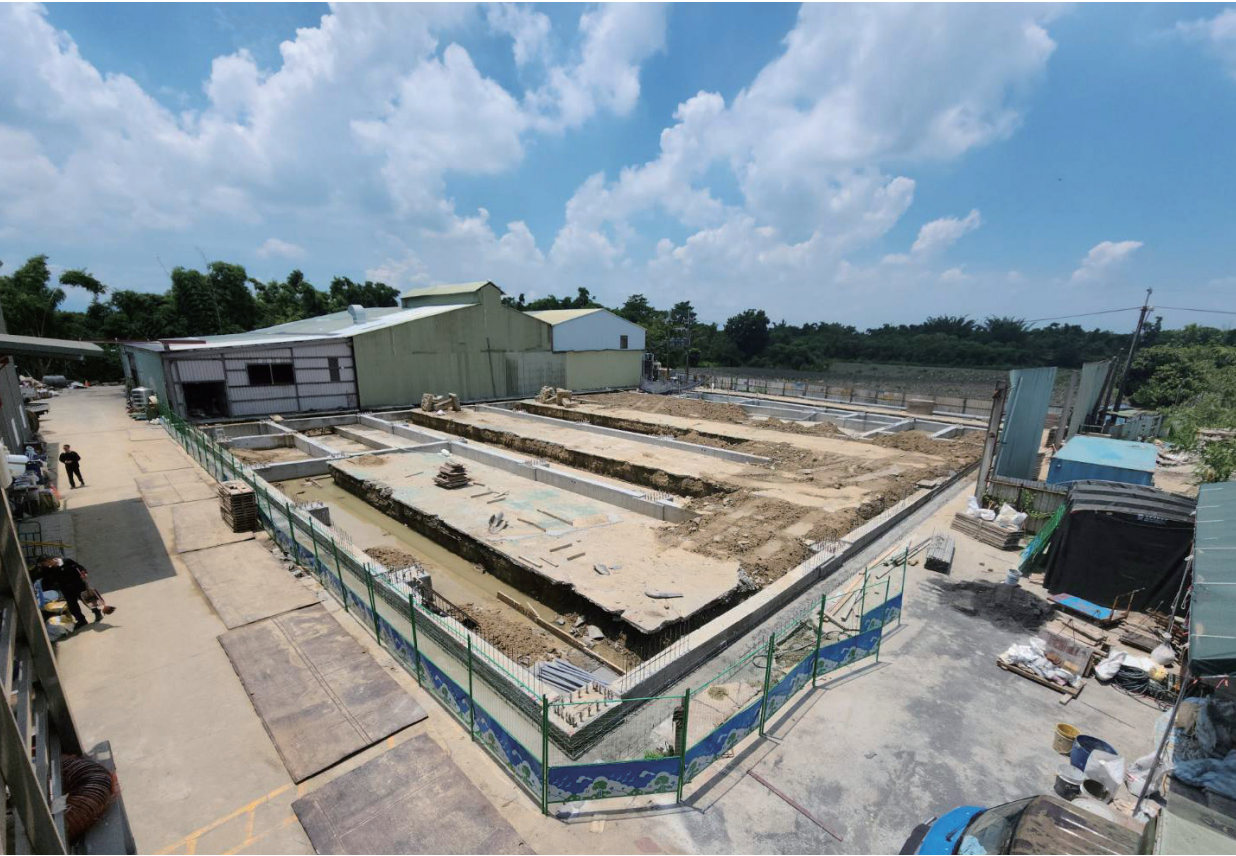
為了拚在土地及建物合法期限，成為合法工廠，陳明順下決心拆除 500 坪的工廠進行重建，以符合法規。
